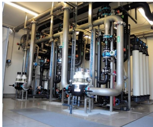
Vodarna Virje z ultra filtracijskimi enotami
